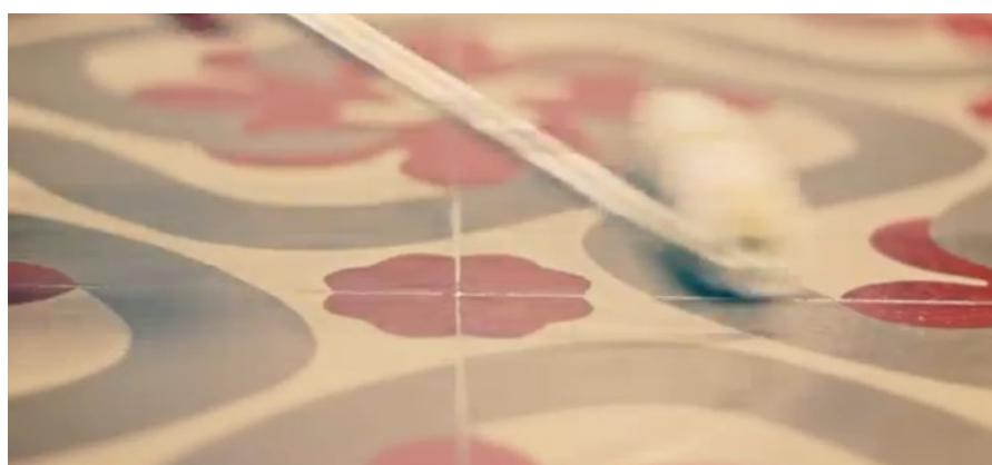
Placutele sunt impermeabilizate atunci cand apa nu mai intra in ele. Faceti o proba cu un strop de apa pe care il lasati sa cada pe o placă. Daca stropul nu penetreaza suprafata, inseamna ca placutele sunt impermeabilizate.
